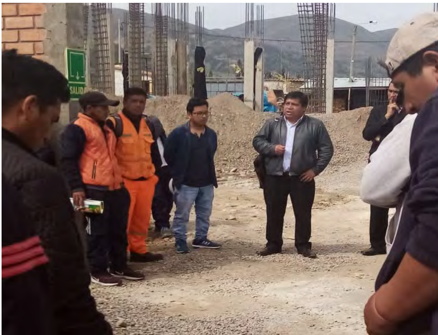
El consejero Tito Castro realiza visita de supervisión a la obra: Construcción de la Infraestructura de la Gerencia Sub Regional de Tayacaja.
